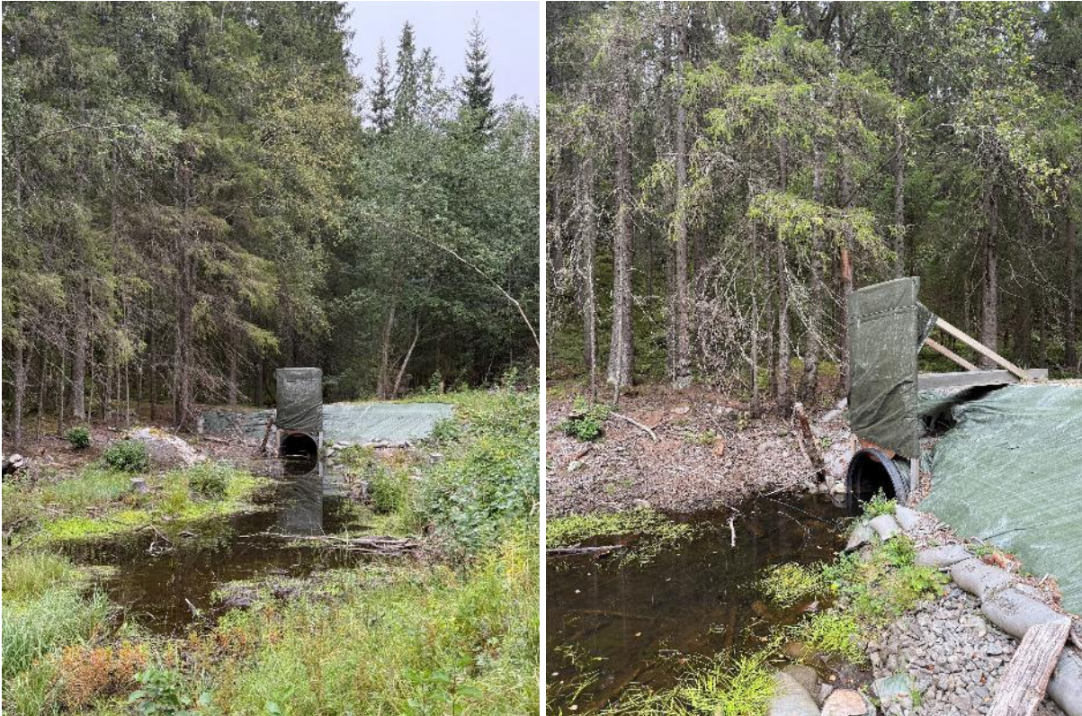
Figur 4.5. Demning nedstrøms utløpet av Fjerdingsbydammen. Bildet er fra befarings i høsten 2025. Foto: Kristine Andersen, Sweco.
